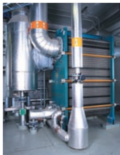
Конденсатор этанола. Компания Absolut (Швеция). Все колонны компании Absolut на дистилляционном заводе в г. Bhus имеют ребойлеры и конденсаторы компании Альфа Лаваль. Аппараты Альфа Лаваль были выбраны в связи с их компактностью.
