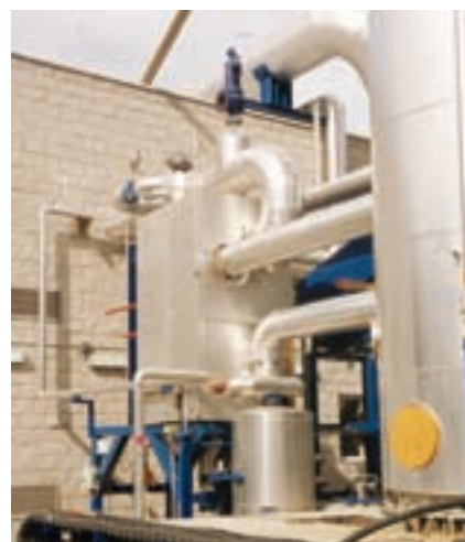
AlfaVar ребойлер, работающий по принципу термосифона, на заводе Carbonesco (Испания)
